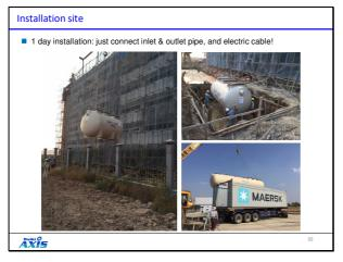
FRP浄化槽は既にパッケージされて いるので、施工が簡単です。 設置ベースの準備ができていれば、 設置して配管類をつなげれば完成 です。
