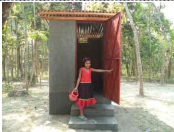
完成したピットラトリン
