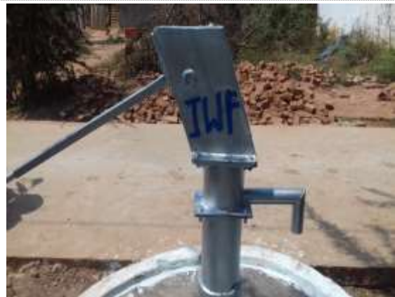
修理したハンドポンプ付き井戸
