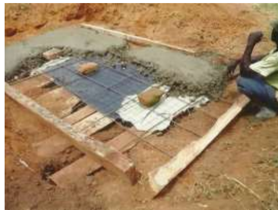
VIP トイレの建設
