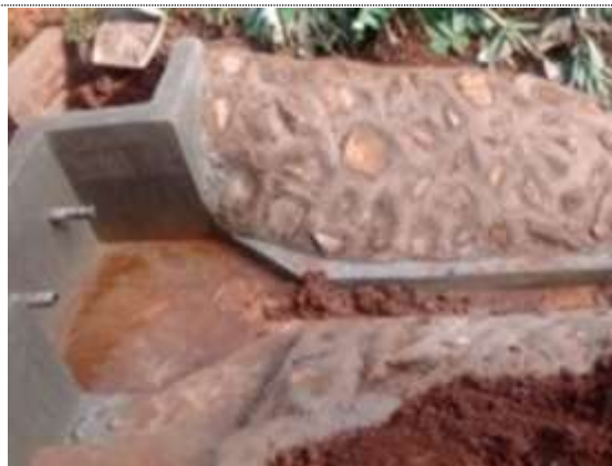
完成した湧水保護設備
