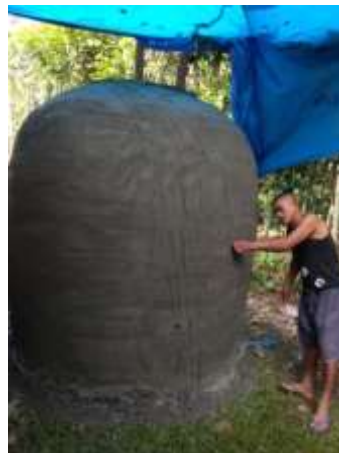
雨水貯留タンクの建設
