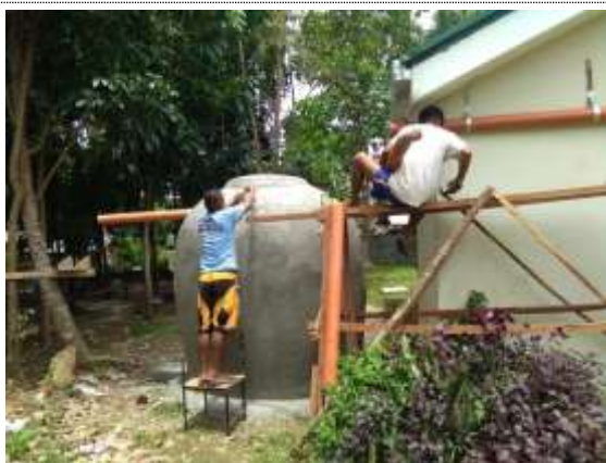
雨水を集める配管の設置
