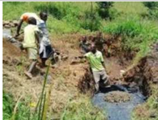
湧水保護設備の建設
