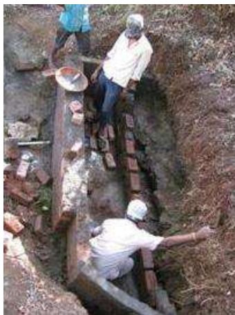
湧水保護設備の建設
