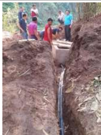
給水配管の修理と埋設
