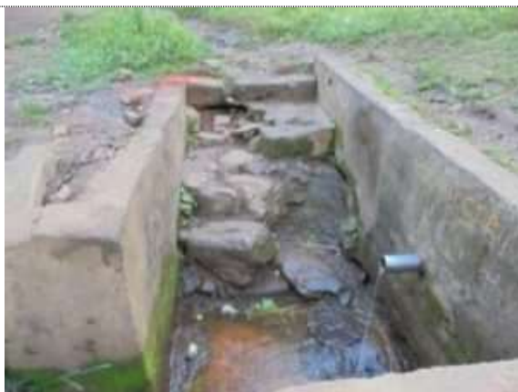
アリモにある給水設備
