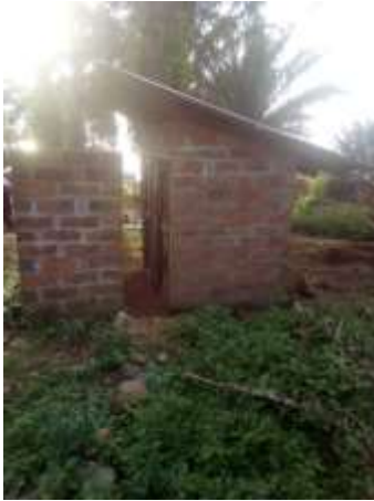
完成したピットラトリン
