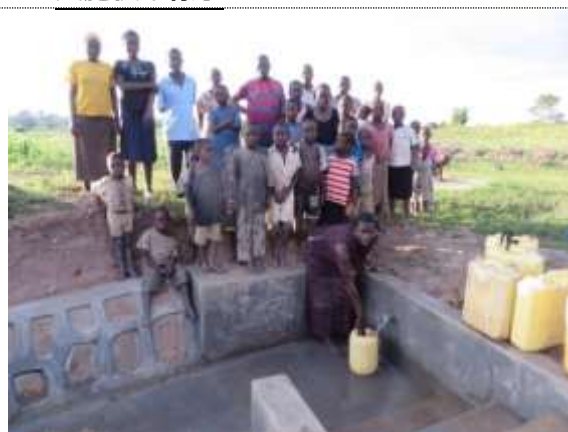
完成した湧水保護設備と住民たち
