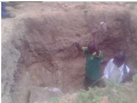
汚水槽の掘削
