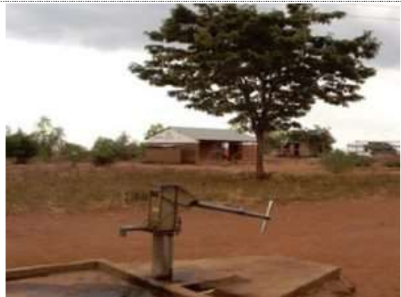
修繕予定の既存井戸
