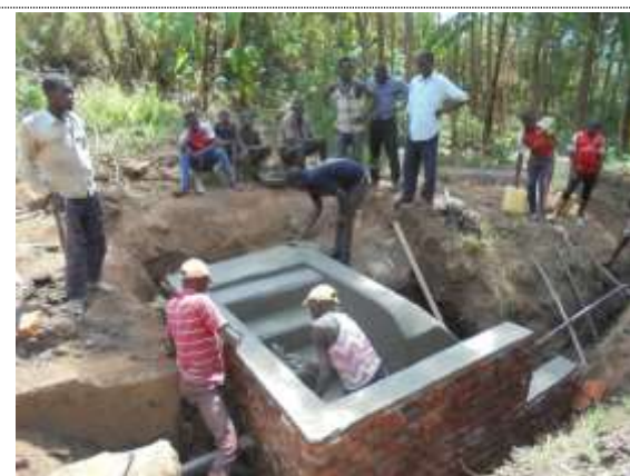
アメレンジュ・アヴブにある給水設備の修繕
