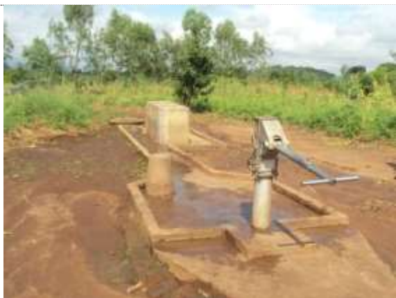
修繕した井戸と洗濯場、排水溝
