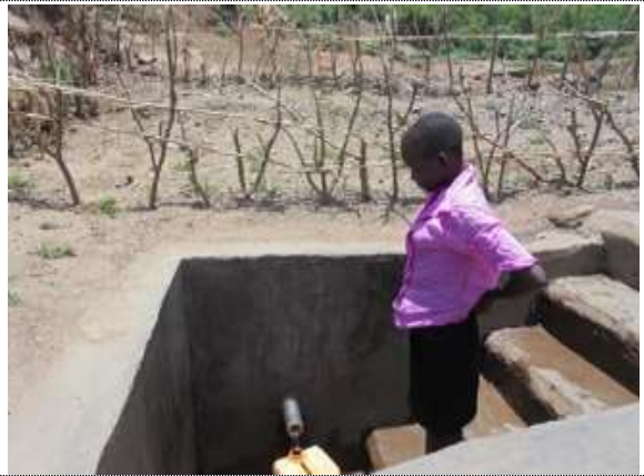
修繕されたアメレンジュ・アヴブの給水設備から水を汲む住民
