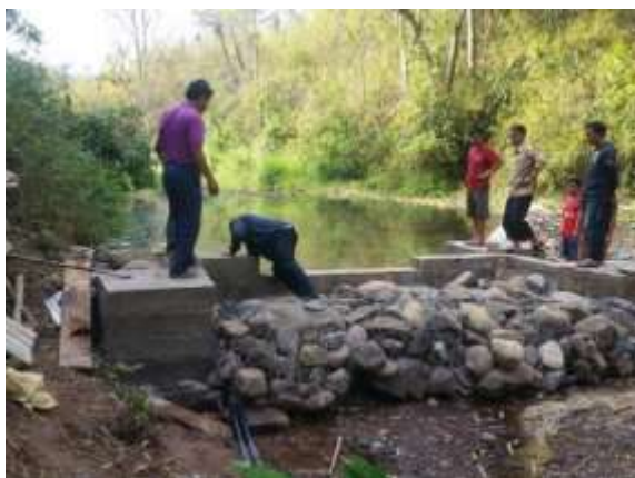
新規の小規模貯水池の建設
