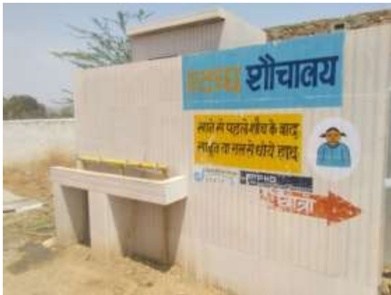
2016年に改修した女子トイレ
