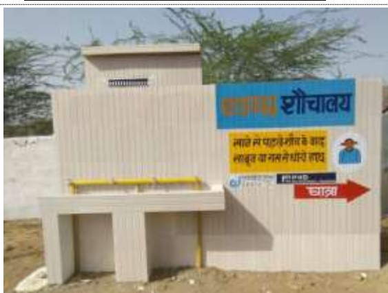
改修した女子生徒用トイレと手洗い場
