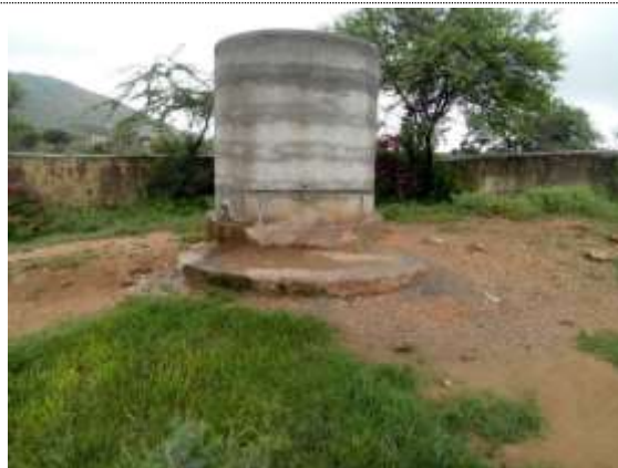
学校の既存給水設備
