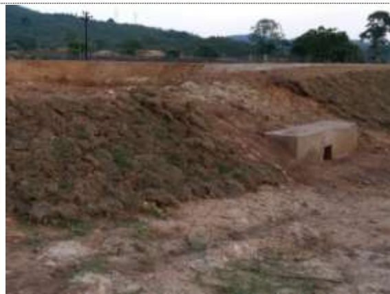
完成した排水路
