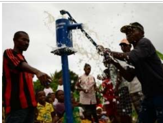
完成したハンドポンプ
