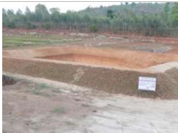
完成した雨水貯留施設
