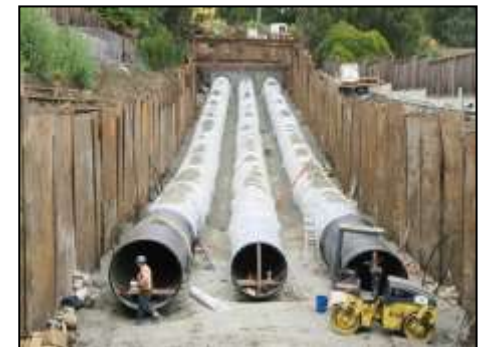
2016（平成28）年 米国・シリコンバレー 導送水管で採用された米国初の大口径 耐震継手管
