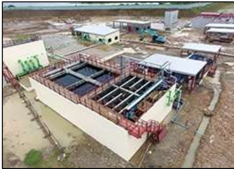
2015（平成27）年 ミャンマー ティワラ地区工業団地の取水・給水配管 の供給と上下水処理施設を一括受注
