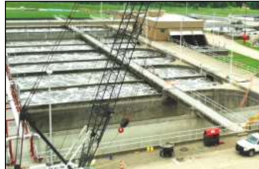
2013（平成25）年 米国・カントン市 北米最大級の水再生処理施設
