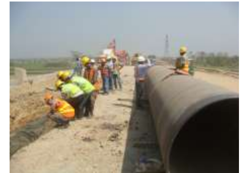
2013（平成25）年 バングラデシュ カルナフル川からチッタゴン市への 送水管の建設工事
