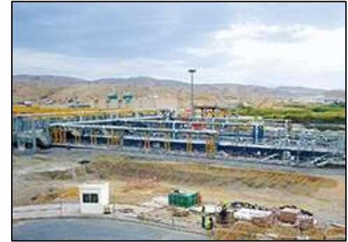
2015（平成27）年 中東 オマーン アルアンサブ下水処理場に 中東最大の下水膜処理装置を建設中
