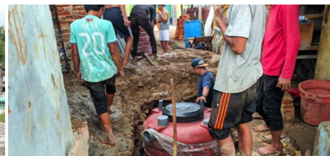
日本企業コラボ:浄化槽設置作業
