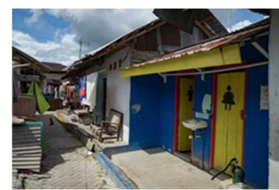
プロジェクト実施後のトイレ
