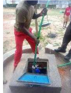
水中ポンプ設置
