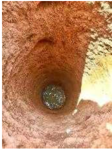
追加掘削後の井戸
