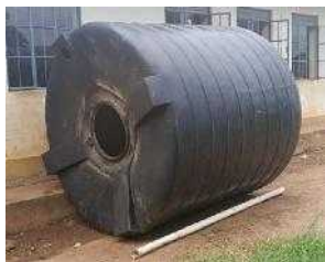
既設雨水貯留槽分解ヒビ割れ穴埋め補修工
