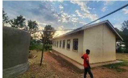
雨樋と貯留槽の接合
