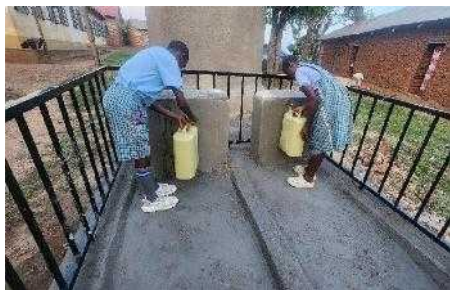
校内の新しい給水栓から安全な水汲み
