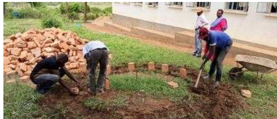
雨水貯留槽基礎工
