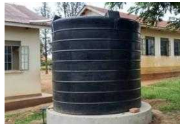
修理した雨水貯留槽の据付
