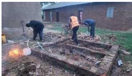
給水栓基礎工
