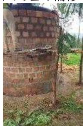
雨水貯留槽ブロック保護工
