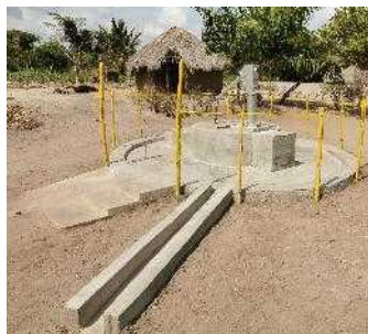
完成した手押しポンプ井戸
