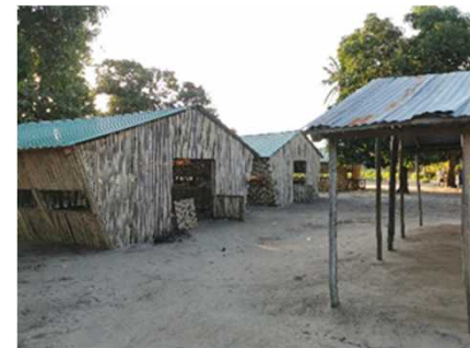
小学校には、清浄な水や基本的な衛生設備がない
