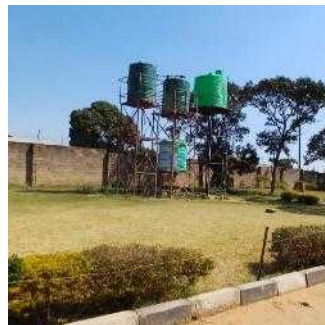
満たされない既設貯水槽4基
