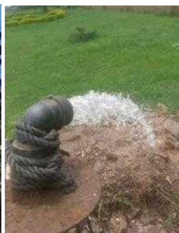
ポンプ補修通水試験
