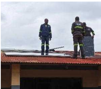
太陽光パネル設置
