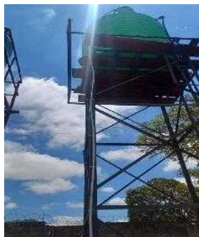
太陽光電力通水試験
