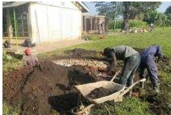
雨水貯留槽基礎工
