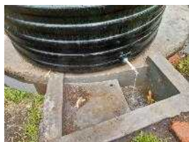
雨水貯留槽水栓の通水
