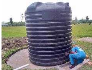
雨水貯留槽設置工
