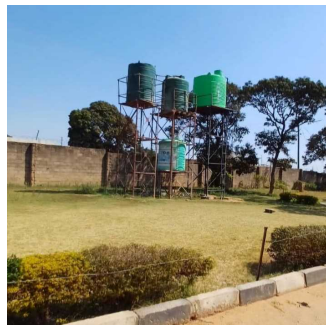
満たされない既設貯水槽4基
