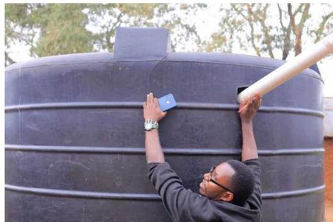
左手付近にヒビあり。本体に穴を空け、雨樋からの横走り管を間に合わせ接合している。
