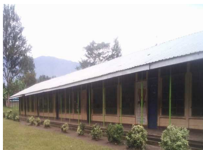
自己水源、雨樋がないキャノンアポロ小学校
