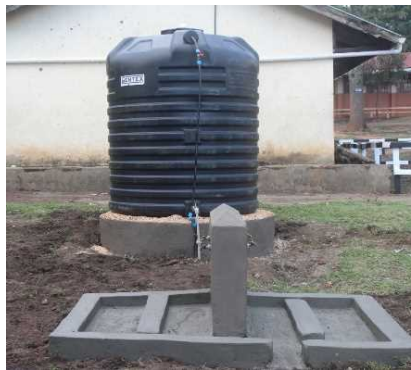
雨水貯留タンク、給水栓設置工
