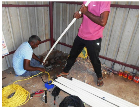
水中ポンプ電気工
