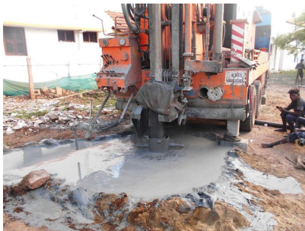
打ち抜き井戸鑿井工
