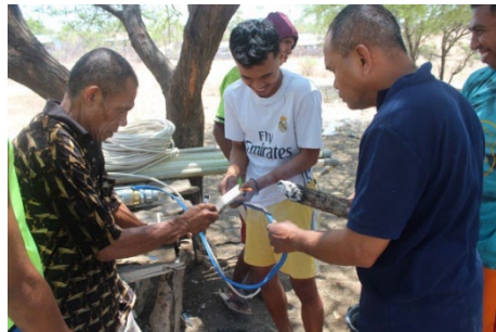
水中ポンプ配管接合工
