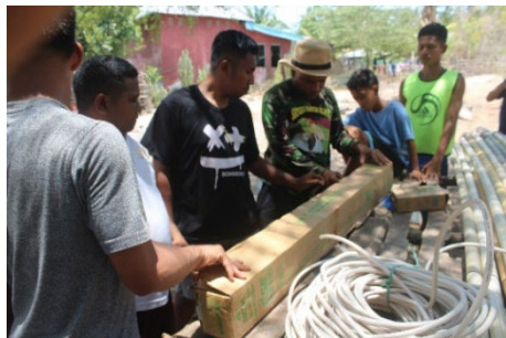
水中ポンプ資材納品検査
