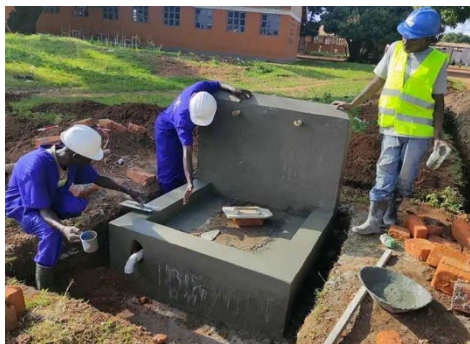
給水栓設置工
