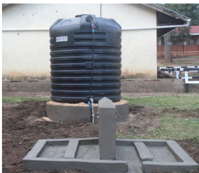
雨水貯留タンク、給水栓設置工
