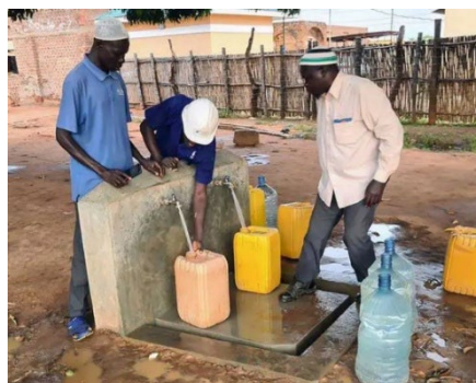
地域給水栓の使用状況
