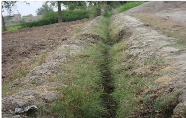
実施前の灌漑用水路
