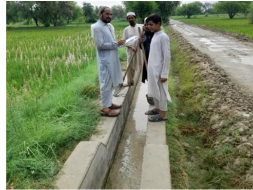
実施後の灌漑用水路
