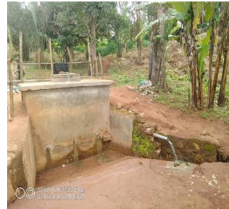
プロジェクトで完成した給水施設
