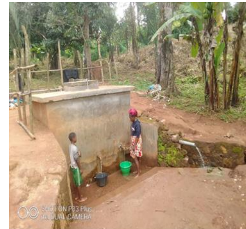
改良された給水施設を利用する子どもたち
