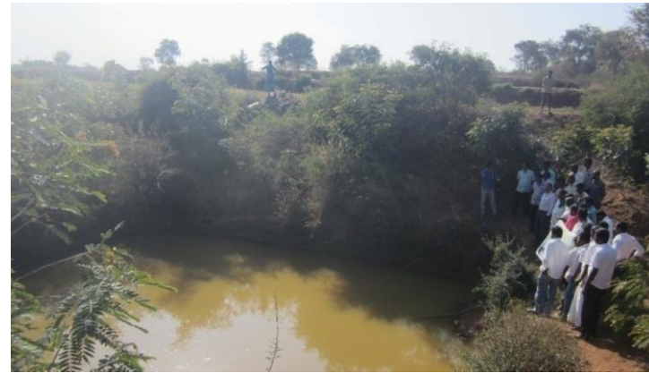
既存の浸透池
