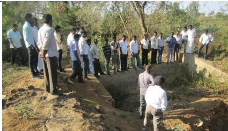
既存のチェックダム
