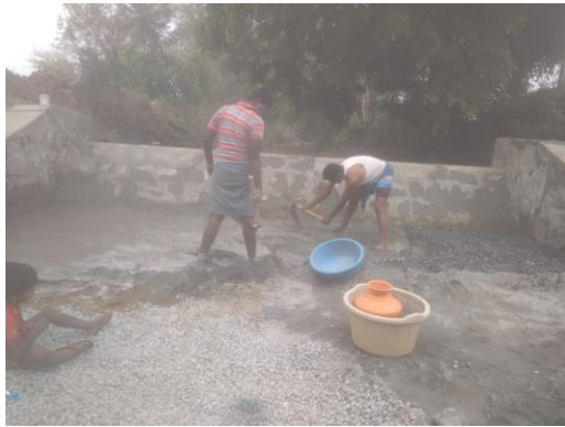
地下水涵養設備の修繕
