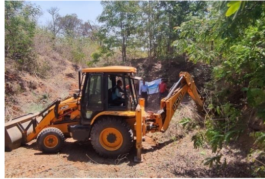
設備周辺の不要林の 撤去と掘削
