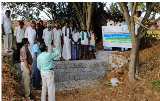
地下水涵養設備の完成
