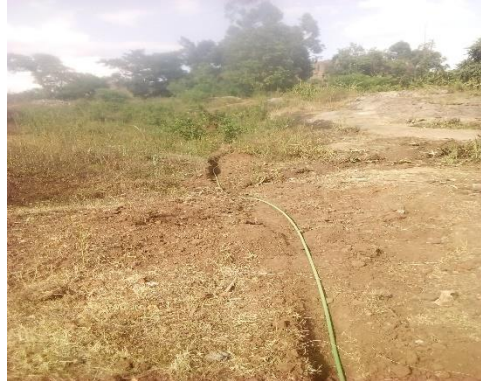
パイプ敷設状況
