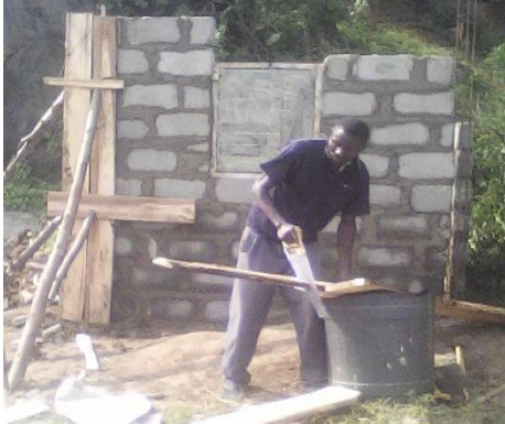
キオスク建設状況
