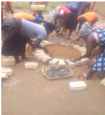
雨水貯留容器の基礎 設置作業
