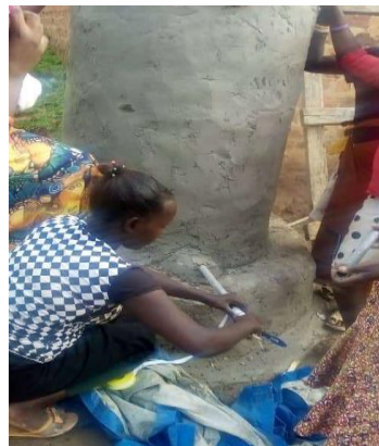
雨水貯留容器の本体 製作
