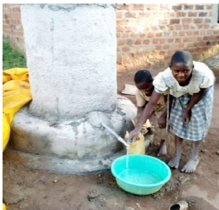
雨水貯留容器からの 給水状況
