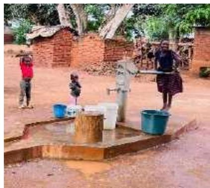
恒久的な井戸にしました。調査会社がセンサーで探査した水源に、機械掘削をしてコンクリートの水受けと手押しポンプを設置しました。
