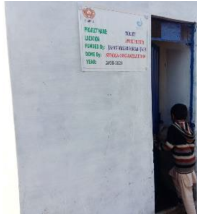
完成したVIPトイレ
