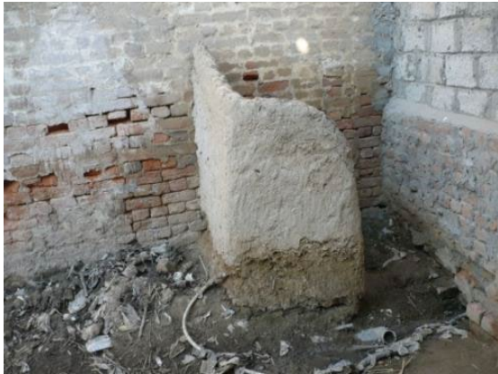
住民がトイレとして使っていたスペース
