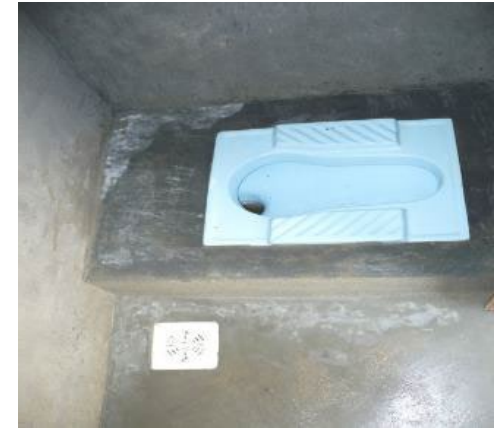
完成したトイレの内部
