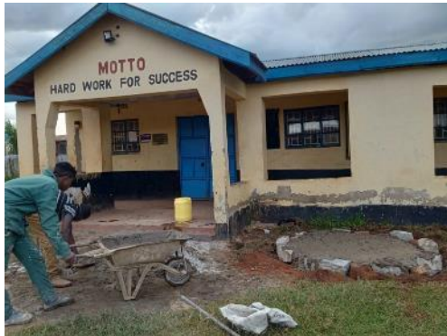
雨水貯留タンク設置の 基礎建設
