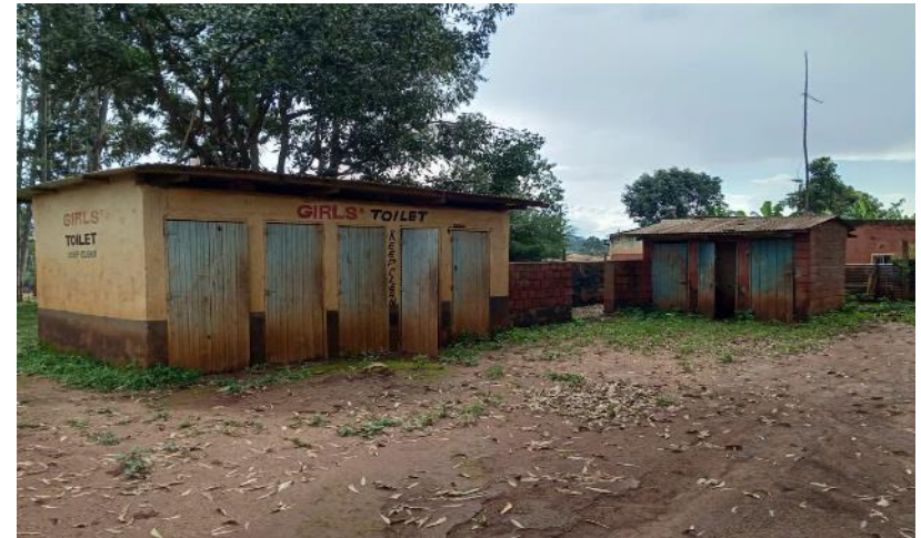
既存トイレには手洗い場がない
