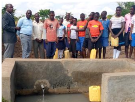
完成した湧水保護設備
