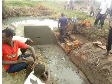
湧水保護設備の建設
