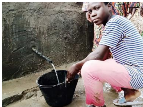
完成した湧水保護設備
