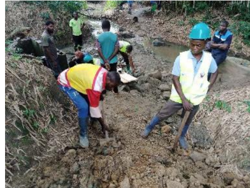
湧水保護設備の建設
