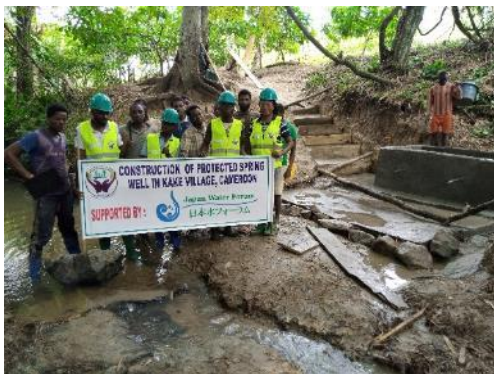
完成した湧水保護設備
