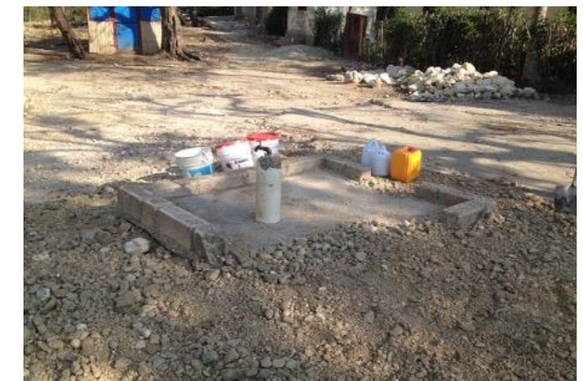
工事中の給水設備
