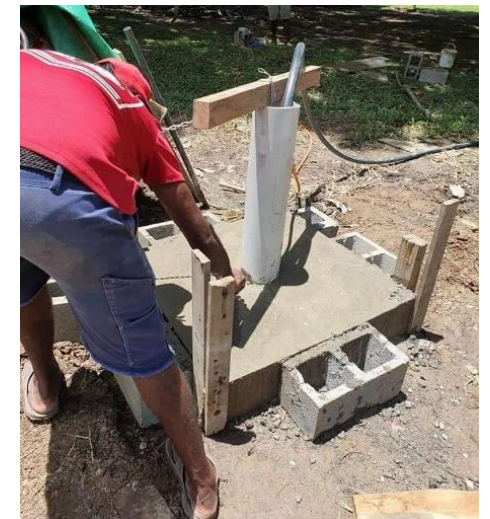
ポンプ設置工事
