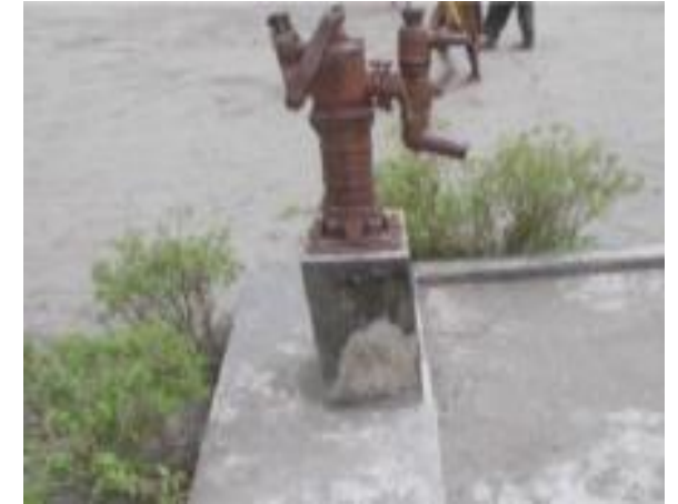
錆により故障したハンドポンプ
