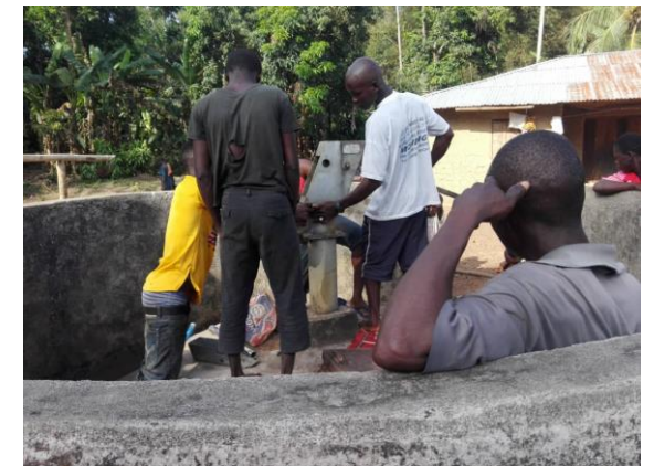
ハンドポンプを修理する 技術者とRACAPのボランティア
