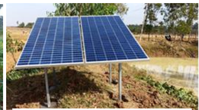
ため池の水を太陽光発電で揚水する
