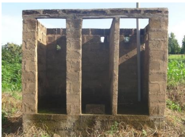
既存のトイレ
