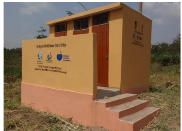
修繕したVIPトイレ
