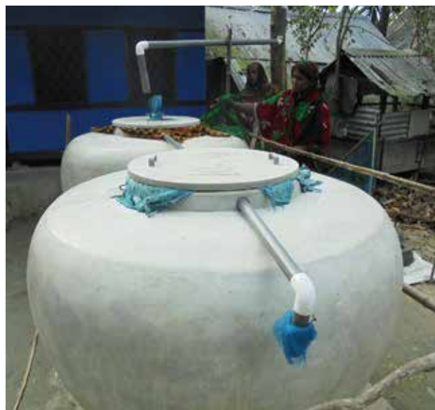
設置した雨水貯留システム
