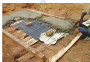
ケニア：トイレ建設の様子
