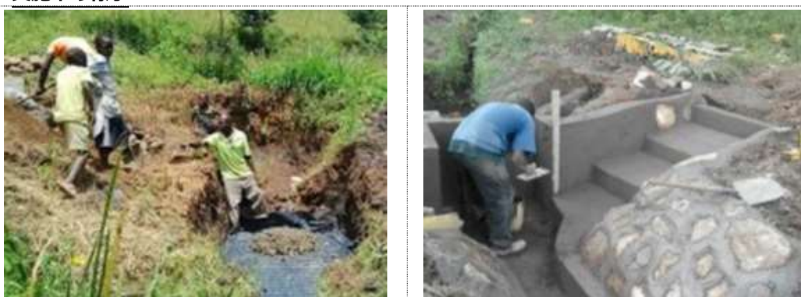
建設中の湧水保護設備
