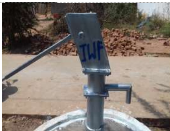
修理したハンドポンプ付き井戸
