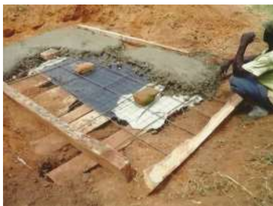
VIP トイレの建設
