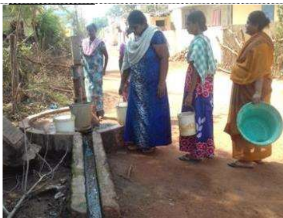
汲み上げた水に泥が混じる既存の井戸
