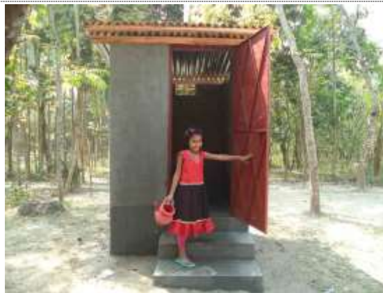
完成したピットラトリン
