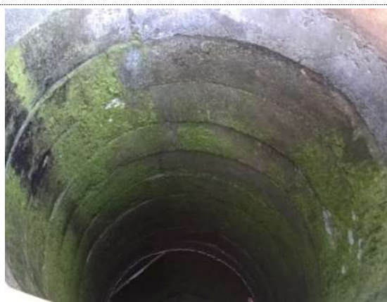
浅井戸の内部は汚れている
