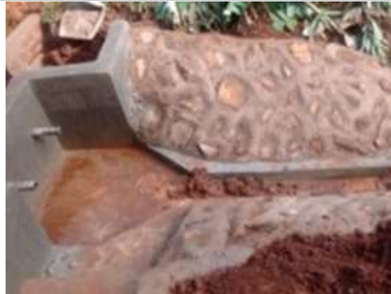
完成した湧水保護設備
