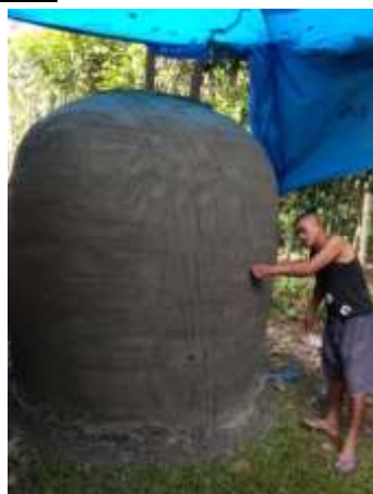
雨水貯留タンクの建設
