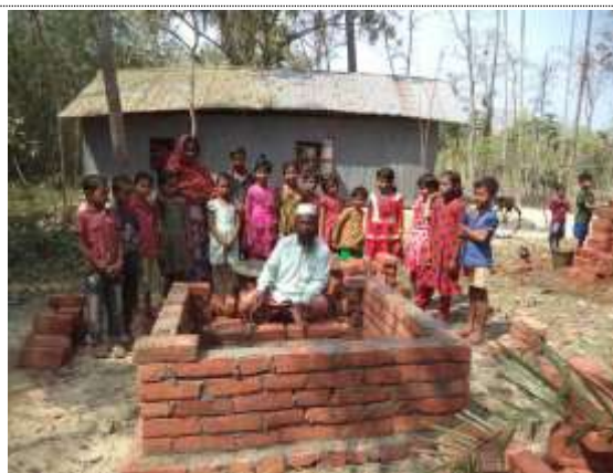
ピットラトリンの建設
