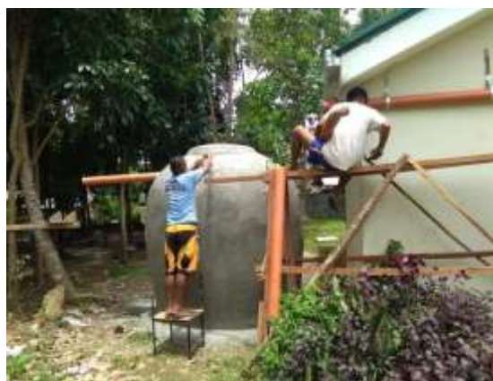
雨水を集める配管の設置
