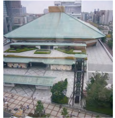
両国国技館 = 1000トン
