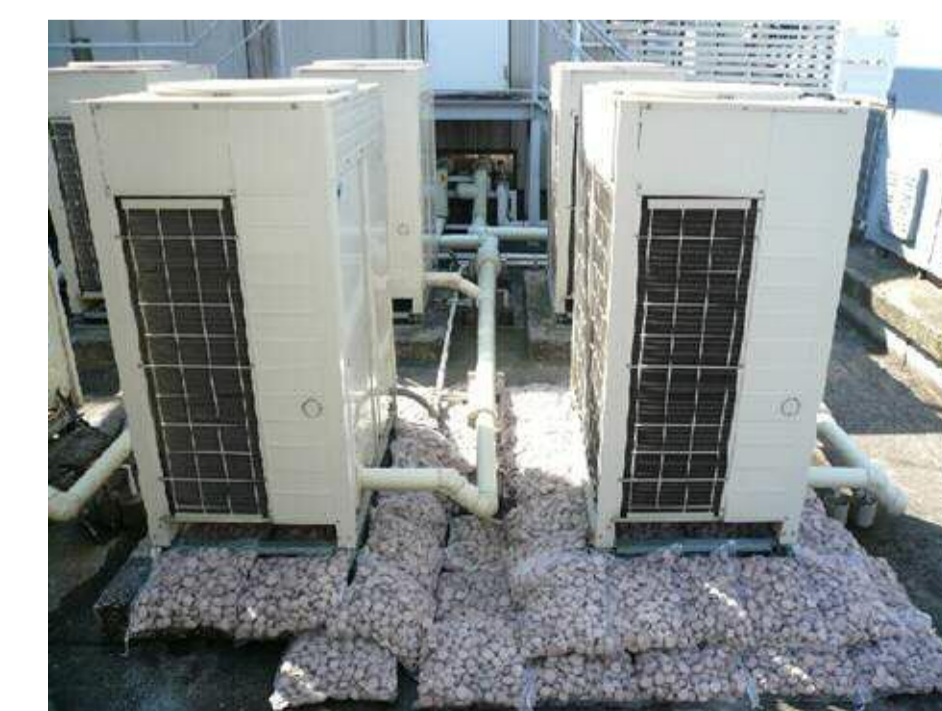
空調室外機周辺 施工事例
