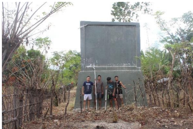
枯草に囲まれた水がない貯水槽
